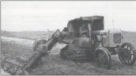
Maschinen sorgten für eine Effizienzsteigerung.
